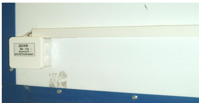
Рисунок 13 – Установка распределительной коробки
