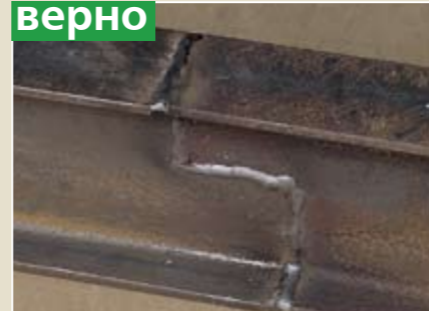
Настолько же удачен и ступенчатый стык, хотя вырезать его – трудоемкий процесс.
