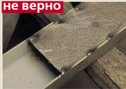
Прямоугольный усиливающий элемент обрывается слишком резко, что мешает нормальному расположению силовых линий
