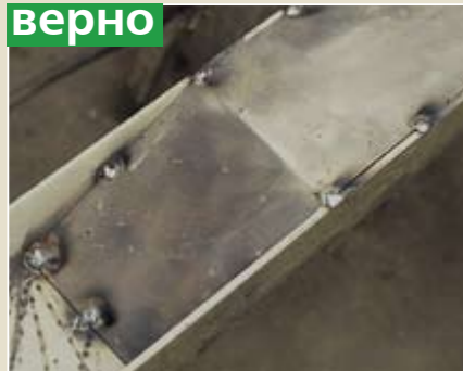
Правильнее будет согнуть пластину и завести ее в U-образный профиль.
