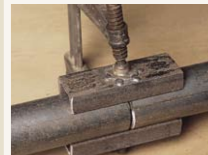
Очень короткую трубу наращивают: концы труб прикладываются один к другому и свариваются. Работу облегчает струбцина с приваренными U-образными профилями. Приспособление позволяет хорошо зажать и одновременно выпрямить трубы.
