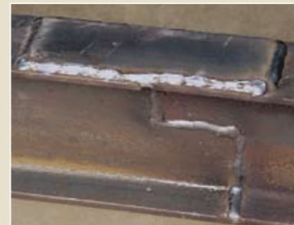
Уменьшение растягивающего усилия на нижней стороне профиля ощутимо повышает несущую способность балки.
