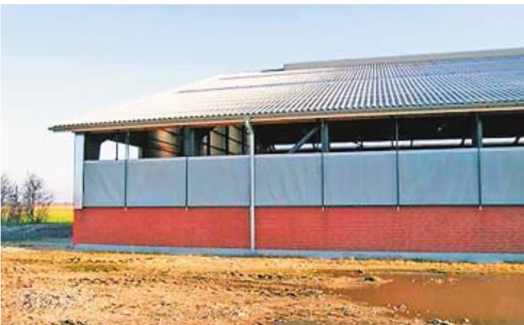
Рис. 4. Нижнюю часть продольных стен для защиты коров от холодного ветра необходимо выполнять глухой на высоту не менее 1,2 м
